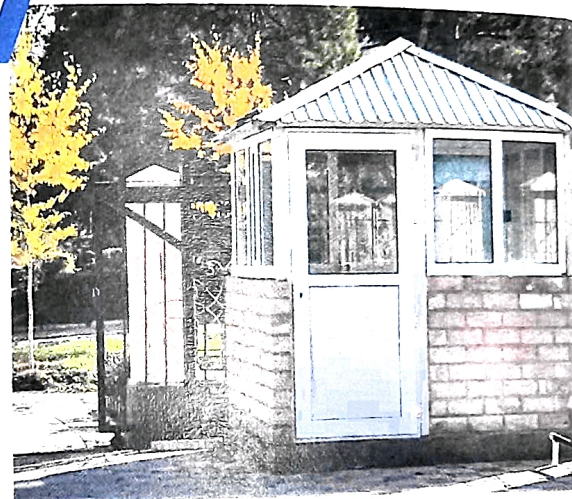
Охранно-пропускной пункт на территории гостевого дома
