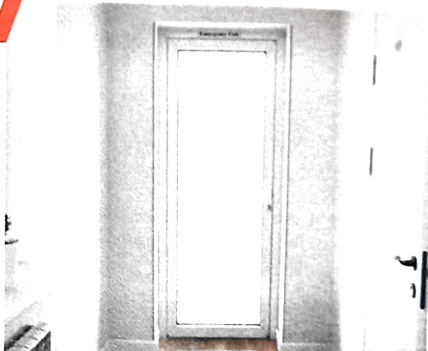
Доступ к двери эвакуационного выхода должен быть свободен
